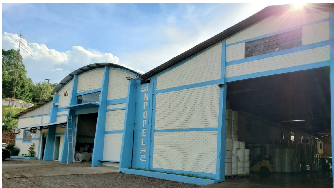
Figura 5: Fachada da empresa
